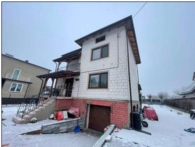
Widok elewacji budynku
